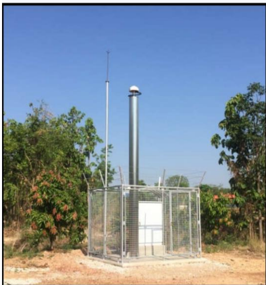
ติดตั้งบนพื้นดิน
